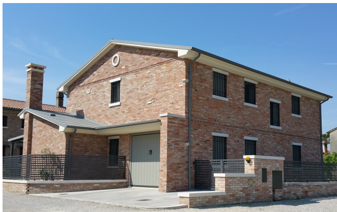
costruzione di un fabbricato ad uso residenziale | superficie 200 mq, volume 1100 mc | Villanova di Camposampiero, Padova | progettazione architettonica e strutturale, direzione e contabilità dei lavori, coordinamento della sicurezza | 2010
