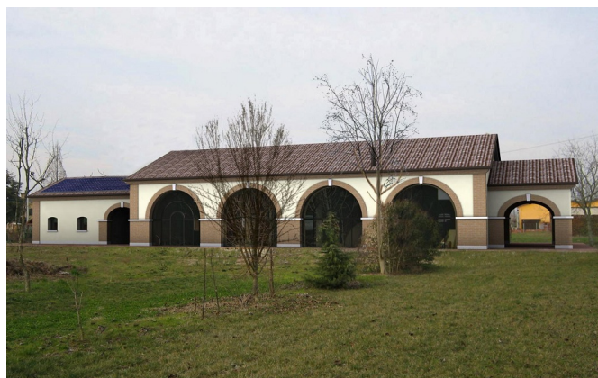
costruzione di un fabbricato ad uso residenziale | superficie 350 mq, volume 1700 mc | Villanova di Camposampiero, Padova | progettazione architettonica e strutturale, direzione e contabilità dei lavori, coordinamento della sicurezza | 2010
