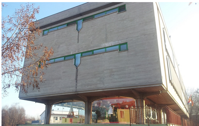
ristrutturazione di un fabbricato vincolato ad uso scolastico | superficie 600 mq, volume 5000 mc | Santa Giustina in Colle, Padova | verifica strutturale | 2011
