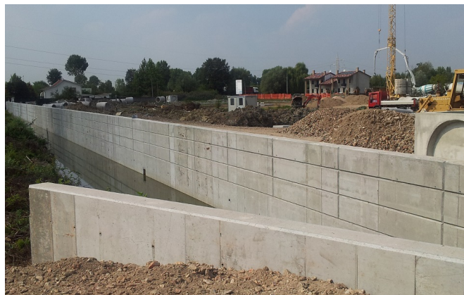
opere di sostegno, piano di lottizzazione ad uso residenziale | superficie 22000 mq | Salzano, Venezia | progettazione strutturale | 2011
