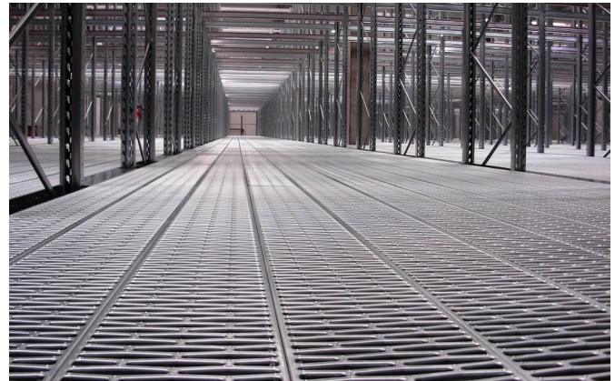
gradino industrializzato e piano carrellabile | analisi e verifica strutturale | 2012
