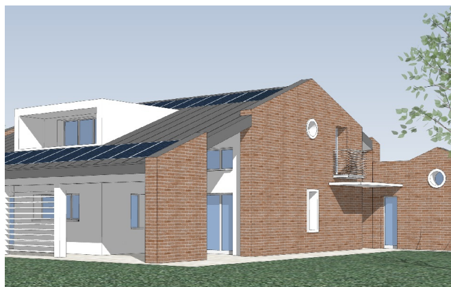
costruzione di un fabbricato ad uso residenziale | superficie 400 mq, volume 2000 mc | Saccolongo, Padova | progettazione architettonica, strutturale e infrastrutturale idraulica, direzione e contabilità dei lavori, coordinamento della sicurezza | 2013
