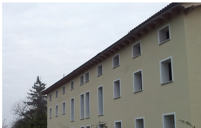
ristrutturazione di un complesso edilizio ad uso residenziale | superficie 1100 mq, volume 3500 mc | Boara Pisani, Padova | progettazione strutturale | 2011
