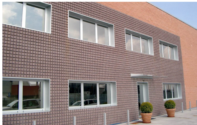
costruzione di un fabbricato ad uso produttivo | superficie 2100 mq, volume 18000 mc | Vigonza, Padova | progettazione architettonica, direzione e contabilità dei lavori | 2004
