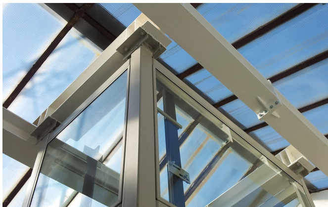
realizzazione di un vano ascensore a servizio di un fabbricato storico ad uso residenziale | Padova | progettazione strutturale | 2013
