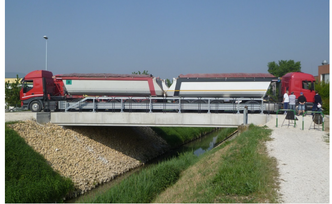
realizzazione di un ponte stradale | luce 16 m | Montegrotto Terme, Padova | progettazione architettonica e strutturale, direzione e contabilità dei lavori | 2008
