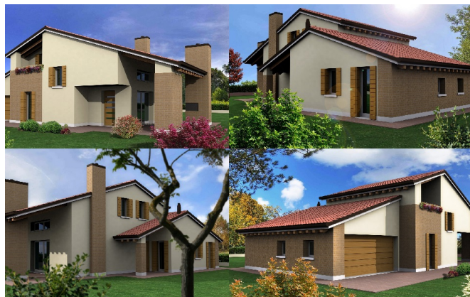
costruzione di un fabbricato ad uso residenziale | superficie 200 mq, volume 900 mc | Villanova di Camposampiero, Padova | progettazione architettonica e strutturale, direzione e contabilità dei lavori, coordinamento della sicurezza | 2011
