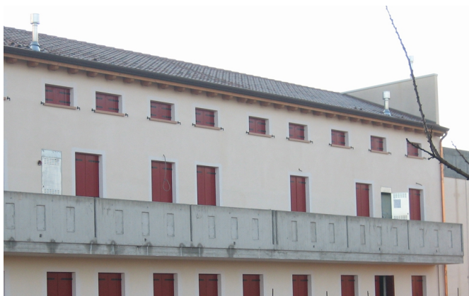
costruzione di un complesso edilizio ad uso residenziale | superficie 3500 mq, volume 9500 mc | Villanova di Camposampiero, Padova | progettazione architettonica e strutturale, direzione e contabilità dei lavori | 2005
