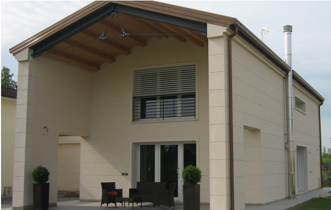
costruzione di un fabbricato ad uso residenziale | superficie 150 mq, volume 900 mc | Villanova di Camposampiero, Padova | progettazione architettonica, strutturale e infrastrutturale idraulica, direzione e contabilità dei lavori, coordinamento della sicurezza | 2008
