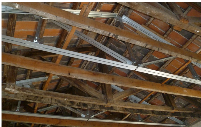
ristutturazione delle strutture di copertura di un fabbricato ad uso produttivo e commerciale | superficie 400 mq | Padova | progettazione strutturale | 2013
