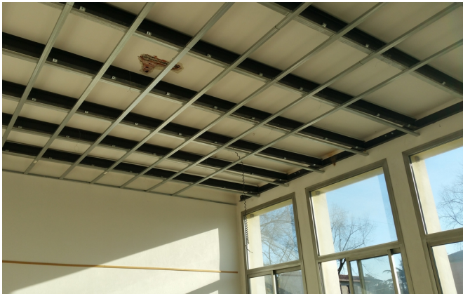
realizzazione di una struttura di protezione all'intradosso dei solai d'interpiano di un fabbricato ad uso scolastico | superficie 600 mq | Mirano, venezia | progettazione strutturale | 2016
