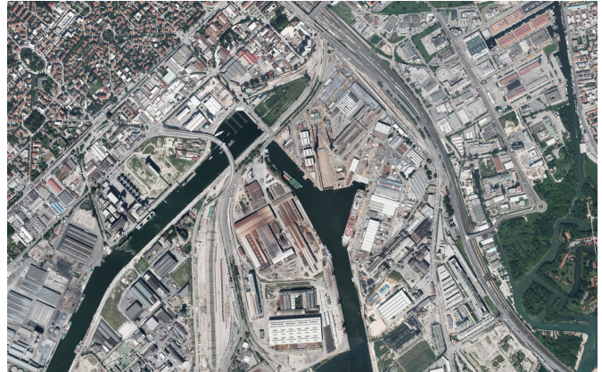
rifacimento della copertura di un fabbricato ad uso produttivo e realizzazione degli apprestamenti per i lavori in quota | superficie 14000 mq | Porto Marghera, Venezia | progettazione strutturale | 2016
