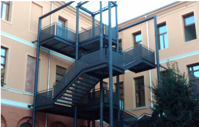
realizzazione di una scala esterna a servizio di un fabbricato ad uso scolastico | Padova | progettazione strutturale | 2009
